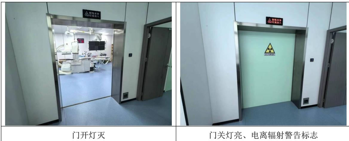
图 3-2 工作状态指示灯、电离辐射警告标志现场图
